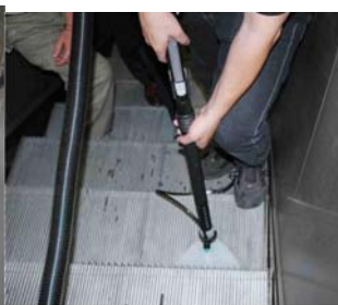
Manuel Aparat ile Escalator dikey basamak temizliği
