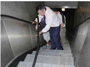
Manuel Aparat ile Escalator dikey basamak temizliği
